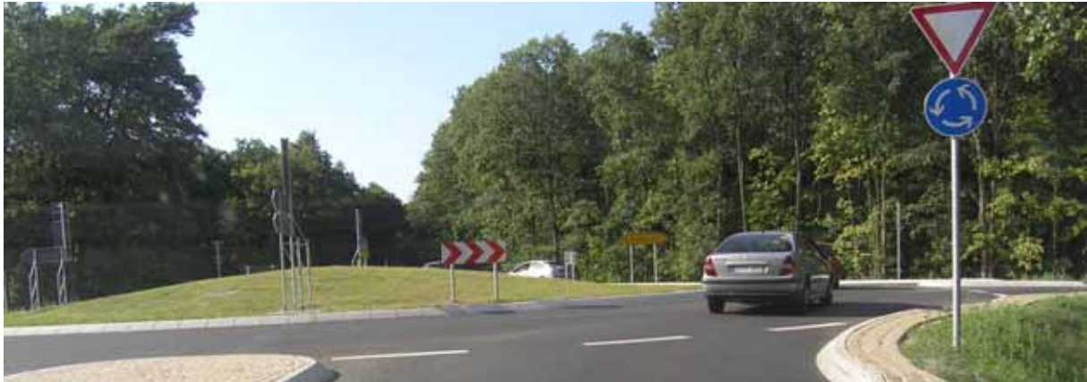
Bild 6-2 Arbeiten an der Kreuzung Freiheitstraße/Friedrich-Engels-Straße (L 401), Stand August 2009-08-17
