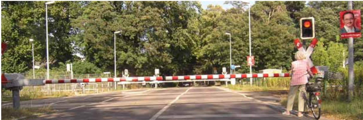
Bild 4-29 Bahnkreuzung 6 – Forstweg, Zeuthen. Direkter Zugang zum Bahnsteig S-Bahnhof Zeuthen, Fahrradabstellanlage auf dem Bahnsteig
