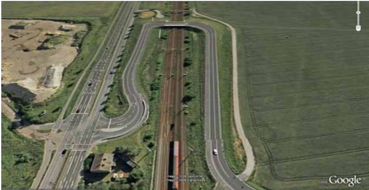
Bild 8-31 Querung der Bahngleise durch eine eng am Bahnkörper geführte Rampe mit einer Brücke, in Schönefeld; die Rampenlänge liegt bei etwa 200 m. Quelle: Google Earth
