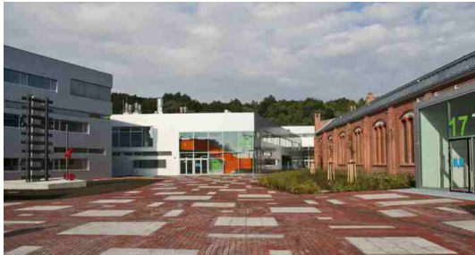
Der neue Campusbereich II mit dem Neubau (Haus 16) und der rekonstruierten Industriehalle 17.
