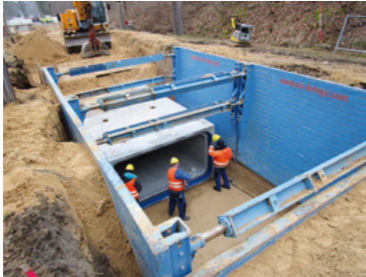
beim Aufbau des Staukanals
